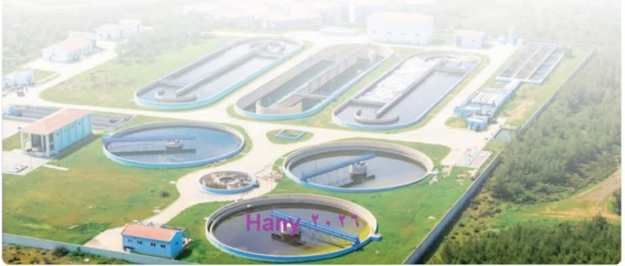
محطة معالجة مياه الصرف
