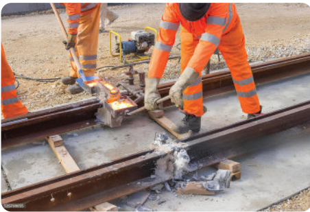
شكل (7) لحام القضبان بتفاعل الترميت
