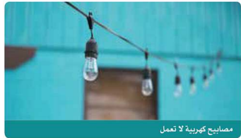
مصابيح كهربائية لا تعمل
