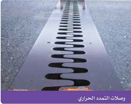
وصلات التمدد الحراري
