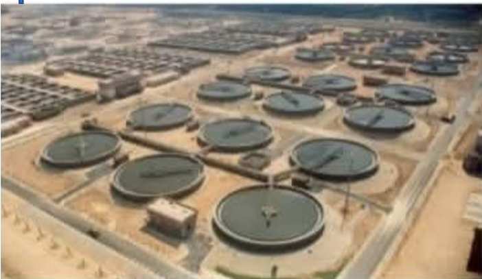
محطة الجبل الأصفر لمعالجة مياه الصرف - القليوبية
