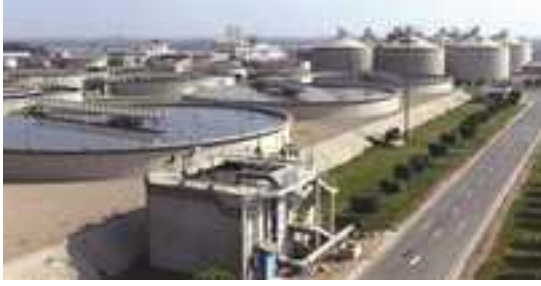
محطة الجبل الأصفر لمعالجة مياه الصرف - القليوبية
